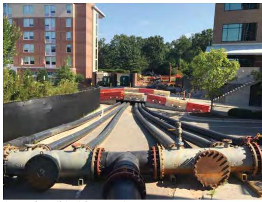
Concrete Road Ramp with six 12-inch HDPE Bypass Lines الكناب أمعم أريمال
